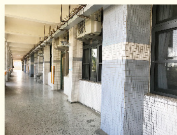
校舍耐震補強(北棟)
