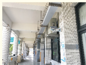
班班有冷氣及電力系統改善工程
