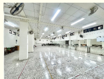
舞蹈教室天花板燈具及排風扇設置
